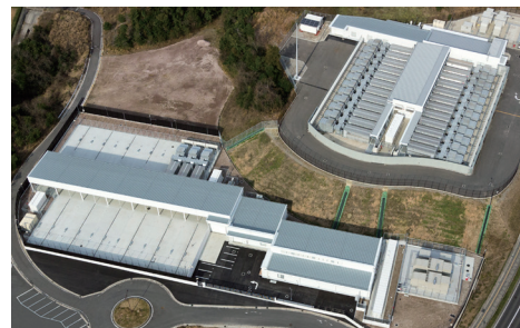
松江データセンターパーク開設（2011年）
